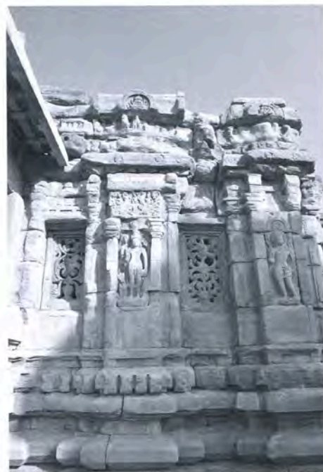
写-12 マリカルジュナ寺院 「外壁の窓と彫刻」
